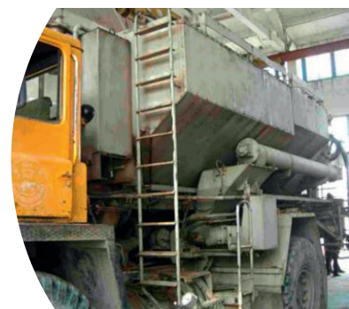
Nitrate d'ammonium Mélange explosif- 100,000 cPo Pompe 60lVA10
