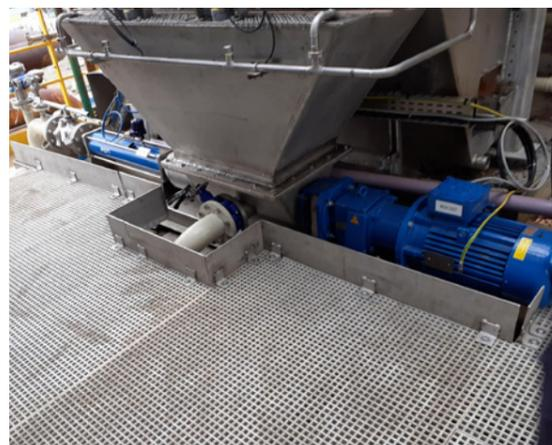
Les pompes Moineau™ sont utilisées en amont pour alimenter les équipements de déshydratation et en aval pour évacuer les boues épaissies des tables d'égouttage ou des presses à vis.
