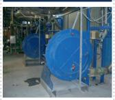
Schlauchpumpe mit gewebeverstärktem Schlauch für hohe Drücke. Druck: bis zu 15 bar.
