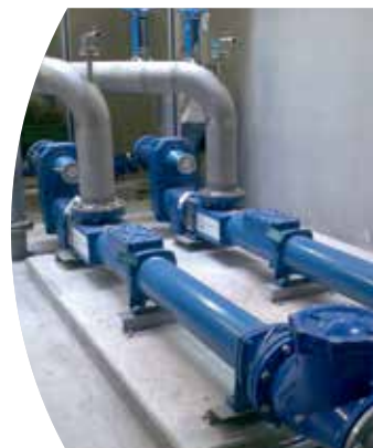
Перекачивание раствора цианида натрия - I-серия. Добыча золота
