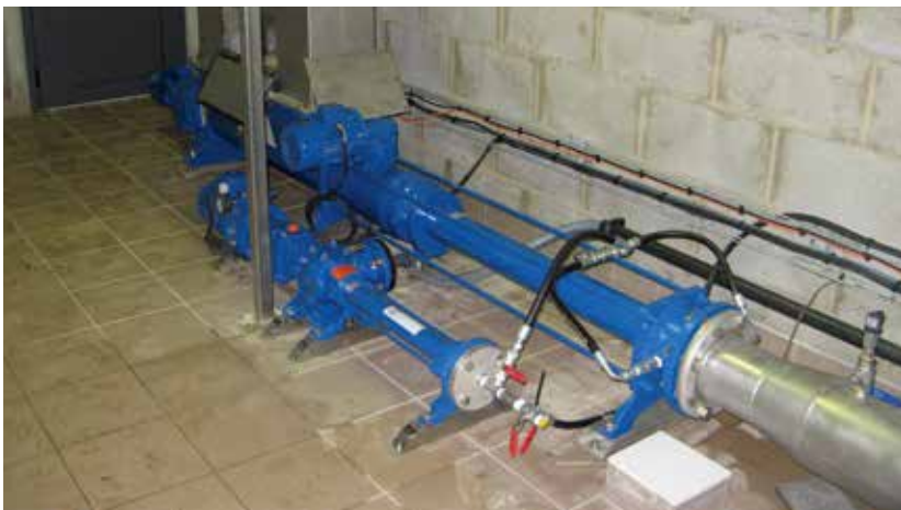
絮凝剂周边注射系统装置配套在GAVO泵上用于泥饼输送
