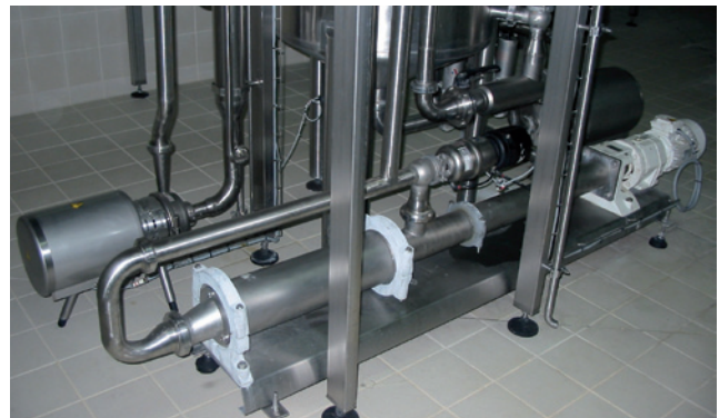
PCM-Pumpe in einer Molkerei
