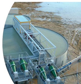
Bombeo de espesador underflow
